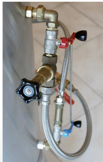
■ Tuyaux et robinets de remplissage
